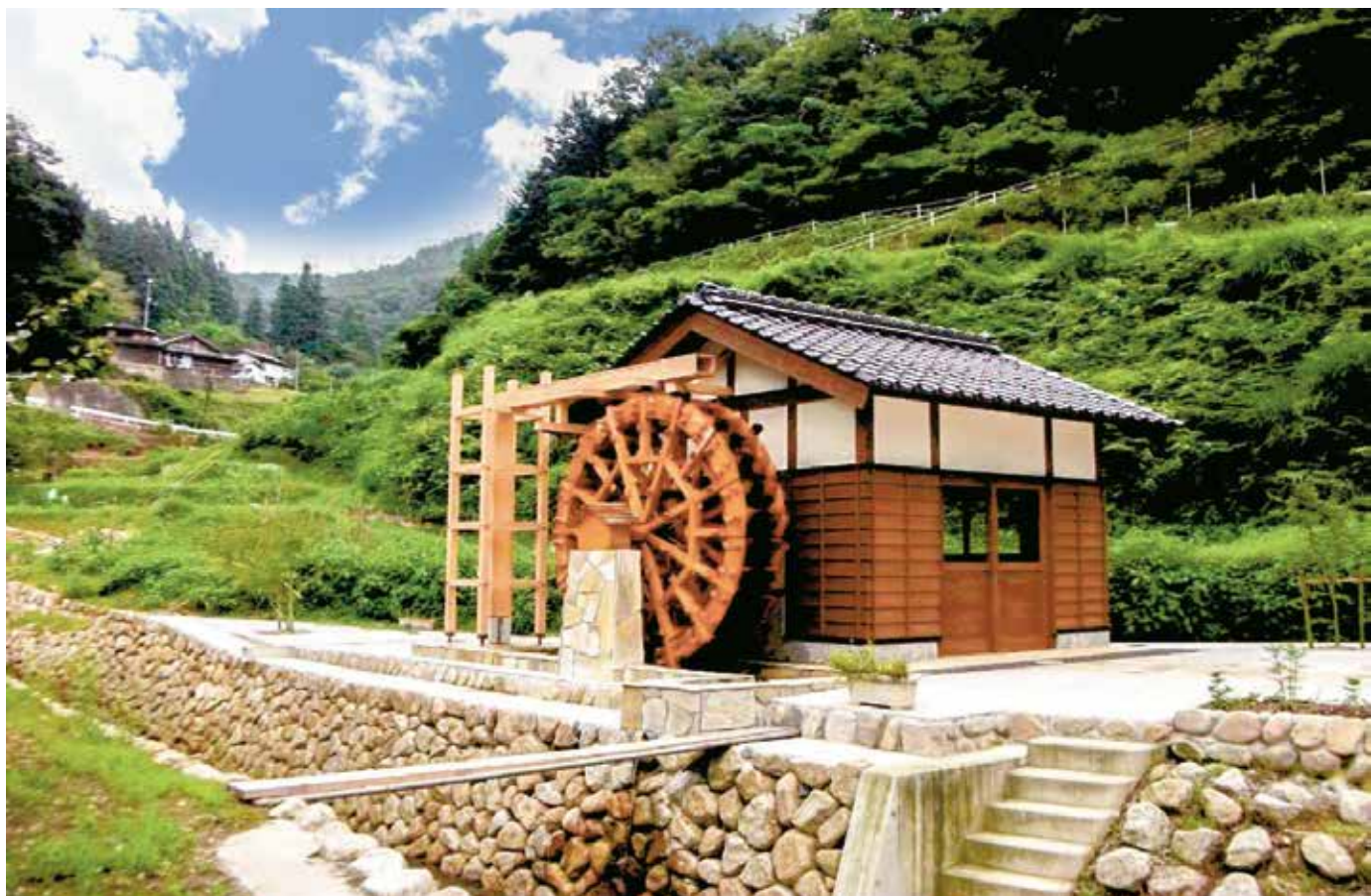
新設時の写真 下は7年経過後の写真
