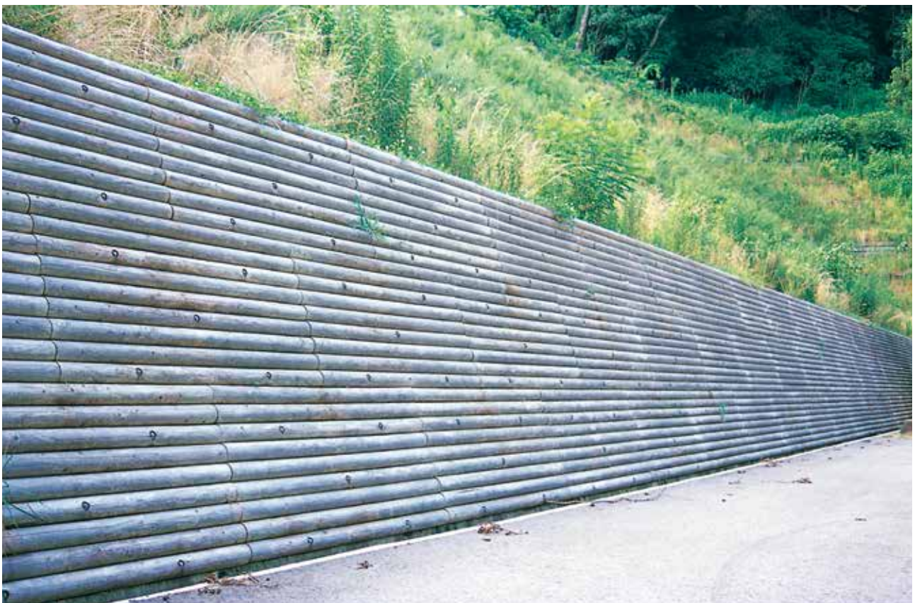
D-0014 型枠工(半丸太)
