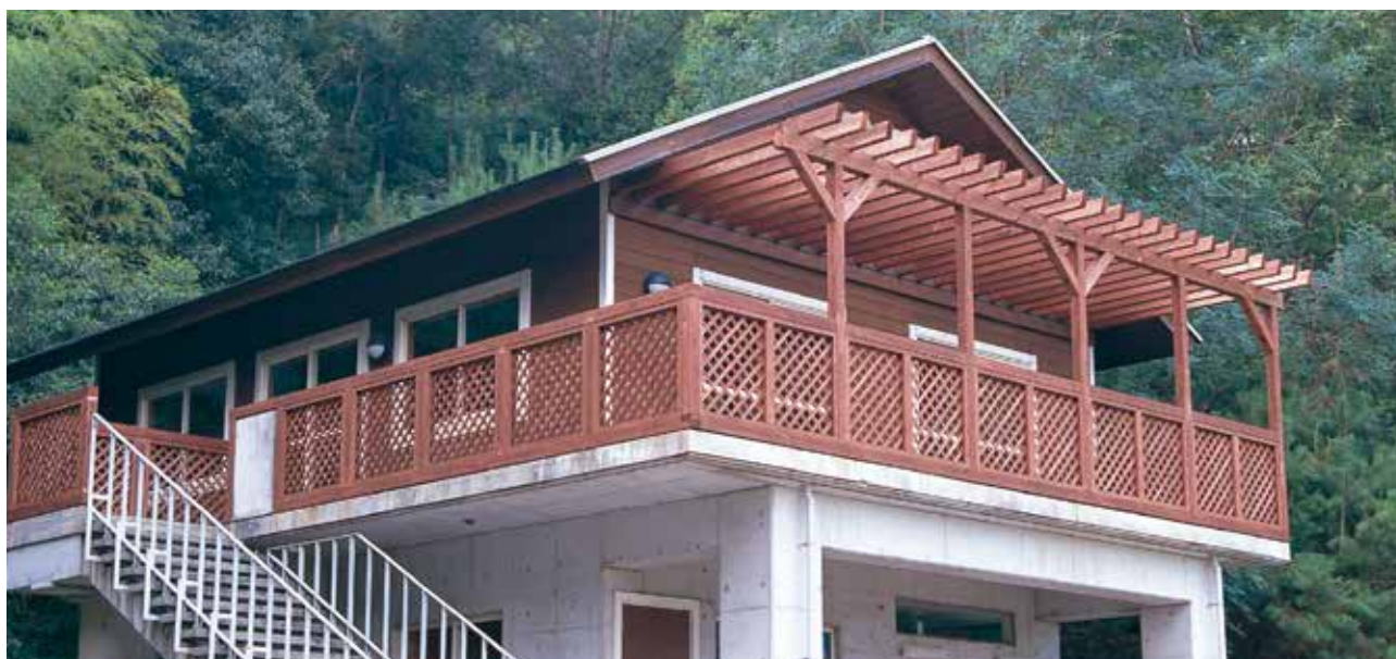
SF-0019 フェンス
